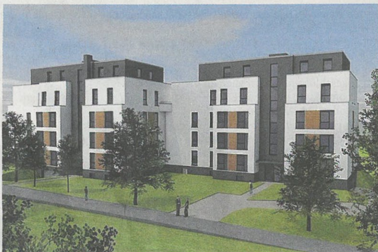
Insgesamt 51 Eigentumswohnungen sollen in solchen Mehrfamilien- sowie in Reihenhäusern entstehen.
